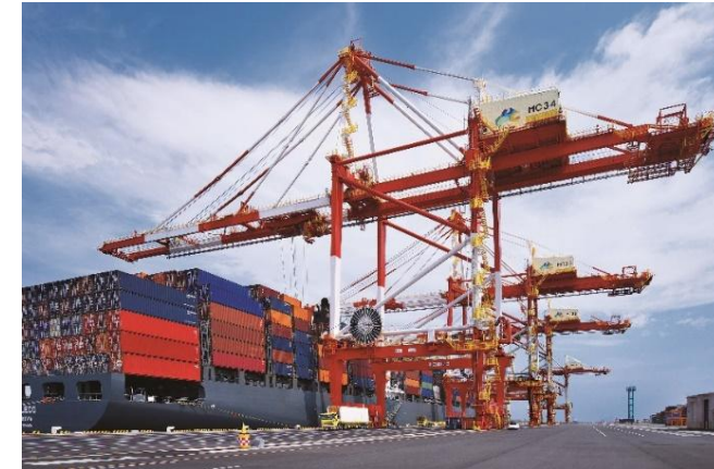
ガントリークレーン
